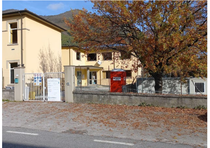
I lavori alla scuola di Diecimo
